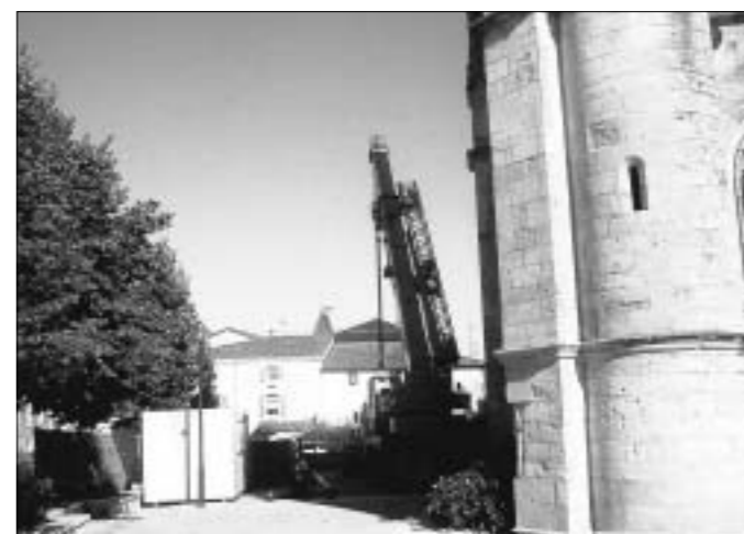
Le matériel de travaux se met en place pour la réfection du pont-levis.
